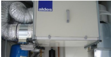
Ventilazione meccanica (portata massima 470 m 3 /h) con recuperatore di calore (>90%)
