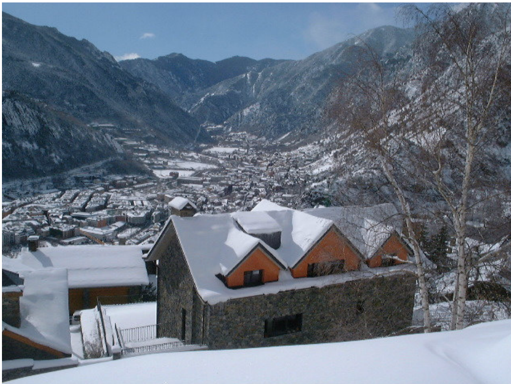
fachadas norte de la casa
