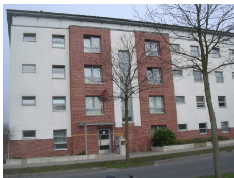
Mehrfamilienhaus mit 8 Wohneinheiten, das Gebäudeluftvolumen beträgt 2.000 m 3
